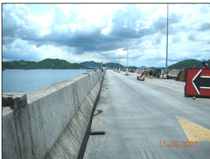
รูปที่ 2.6-1 ข. แสดงคันคอนกรีต และร่องระบายน้ำ บริเวณสะพานท่าเรือ
